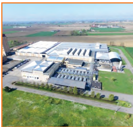
Fig. 2- SAPICI plant in San Cipriano Po Impianto SAPICI di San Cipriano Po
